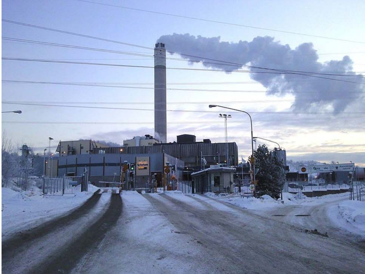
Usine d'incinération des ordures ménagères, Suède. Cliché Mihkkal Buothà
